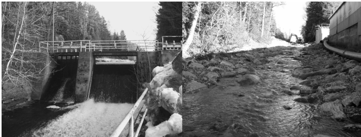
Figur 9. Grönkullen i Sörån – före och efter utrivning av dämme (Foto från Länsstyrelsen i Västra Götaland).
