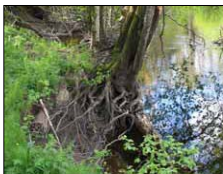
Bild 2. Fickerosion mellan klubbalar i ytterkurva vid Bråta (omr. 7g i sträcka D). Betydelsen av armerande av alrötter syns tydligt.
