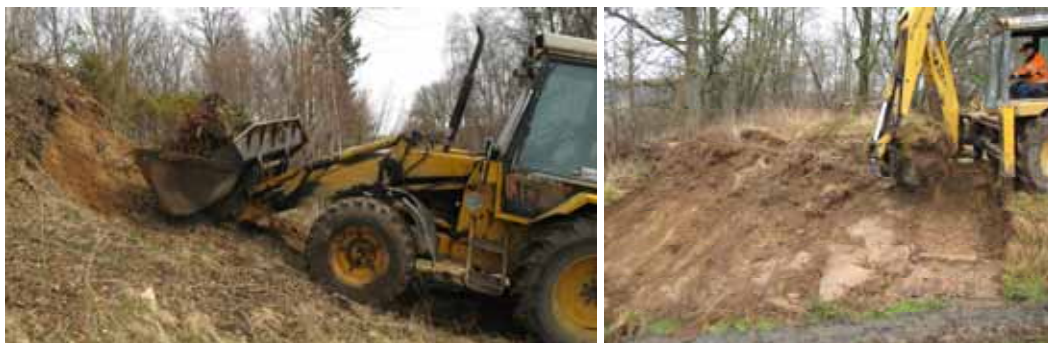
Figur 46 och 47. Johan Nilsson gräver bort en hassel med rötterna som beskuggar en befintlig sandblotta den 26 april 2010 (t.v.). Till höger grävs det översta lagret bort på en igenvuxen vägsränning i område 37 den 11 december 2009.
