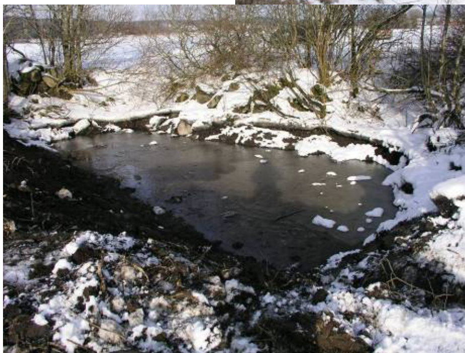
Februari 2006. Bortgrävning av gungfly och fördjupning av vattnet har gjorts. Sett från söder.
