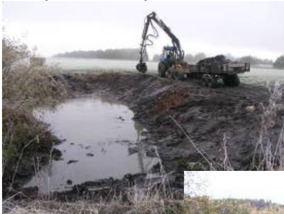
19 oktober 2005 sker grävning av Anders Larsson, Istorp med en skotare försedd med skopa och kärra. För att kunna arbeta fick vatten pumpas ut ur märgelgraven.
