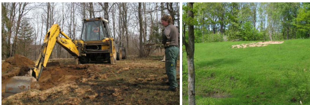
Figur 41 och 42. Johan Nilsson gräver och Peter Åkesson leder arbetet vid grävning av en sandblotta i område 29 den 26 april 2010. Bilden till höger visar platsen den 7 juli 2010.
