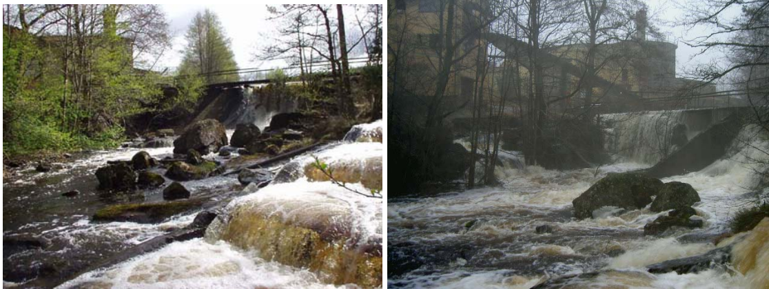
Figur 6 & 7. Dämnet vid lågt respektive högt vattenflöde. (Foto: A. Elm 2003, G. Edlund 2004)
