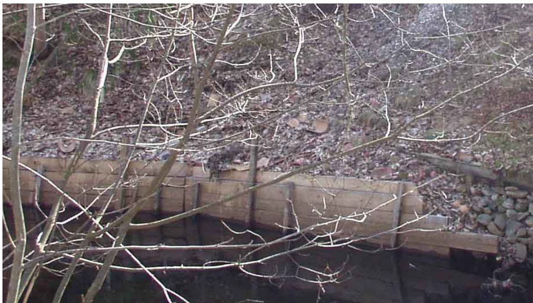
Figur 8. Förstärkning i ytterkurva i Örby samhälle (Foto: A. Elm, 2003)
