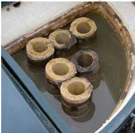
Figur 15. Green Rock 10S där filtren inte bytts ut på flera år (Fotograf: Mika Thomasdotter)
