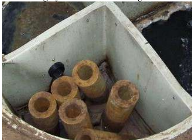
Figur 16. Green Rock 10S där filtren har bytts ut med jämna mellanrum (Fotograf: Mika Thomasdotter).
